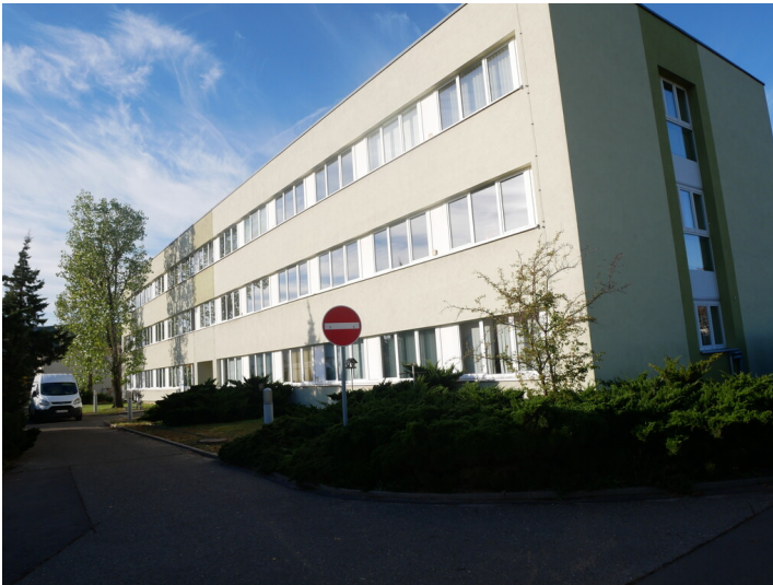
Verwaltung des technischen Service Fotograf/Urheber: Franz Dietzmann
