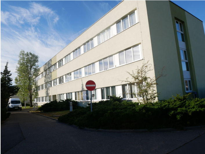
Verwaltung des technischen Service Fotograf/Urheber: Franz Dietzmann
