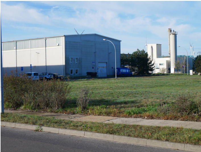
Halle Wareneingang Fotograf/Urheber: Stefan Krug
