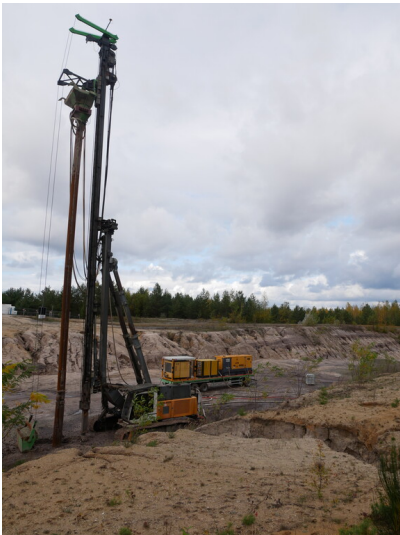
Rüttelstopfverdichtung für Brückenneubau L60 Fotograf/Urheber: Franz Dietzmann
