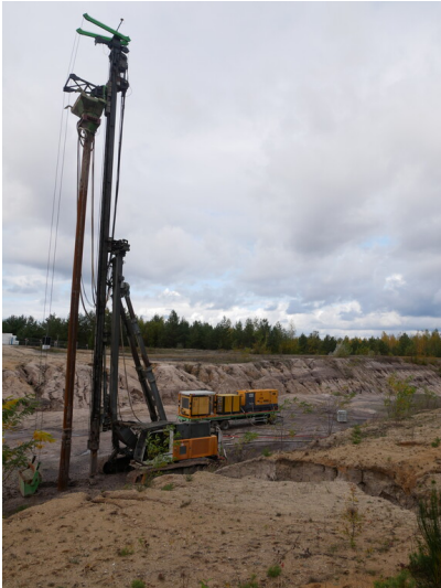
Rüttelstopfverdichtung für Brückenneubau L60 Fotograf/Urheber: Franz Dietzmann
