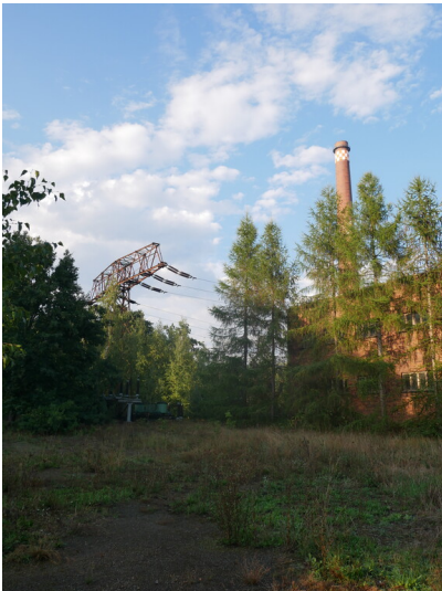
110 kV-Freileitungsmast Fotograf/Urheber: Kaja Boelcke
