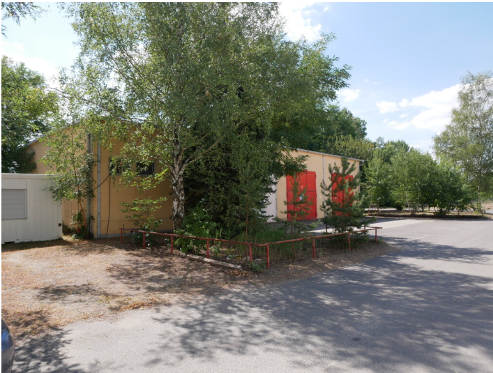
ehem. Tagesanlagen Lichterfeld Fotograf/Urheber: Franz Dietzmann
