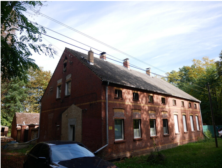
Kontorgebäude Brikettfabrik Felix Fotograf/Urheber: Tanja Trittel
