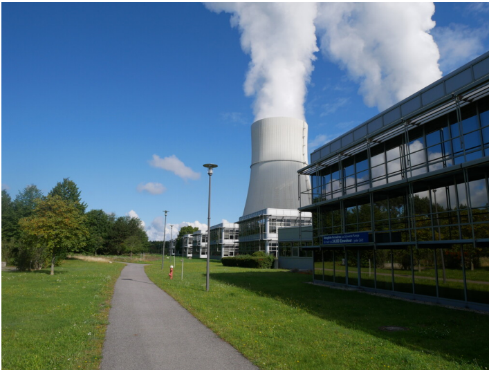
Sozialgebäude Kraftwerk Schwarze Pumpe Fotograf/Urheber: Franz Dietzmann
