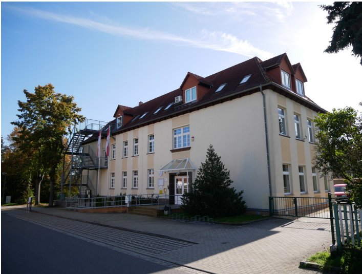
Verwaltung Gemeinde Schipkau Fotograf/Urheber: Kirsten Krepelin
