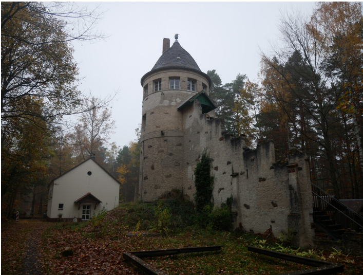
Wasserturm Fotograf/Urheber: Franz Dietzmann
