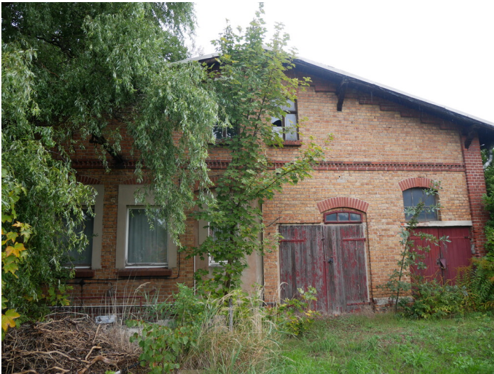
Werkstattgebäude und Werkfeuerwehr Fotograf/Urheber: Dr. Barbara Kündiger
