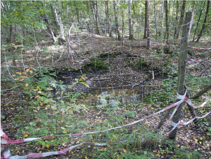
Tagbruch Fotograf/Urheber: Franz Dietzmann
