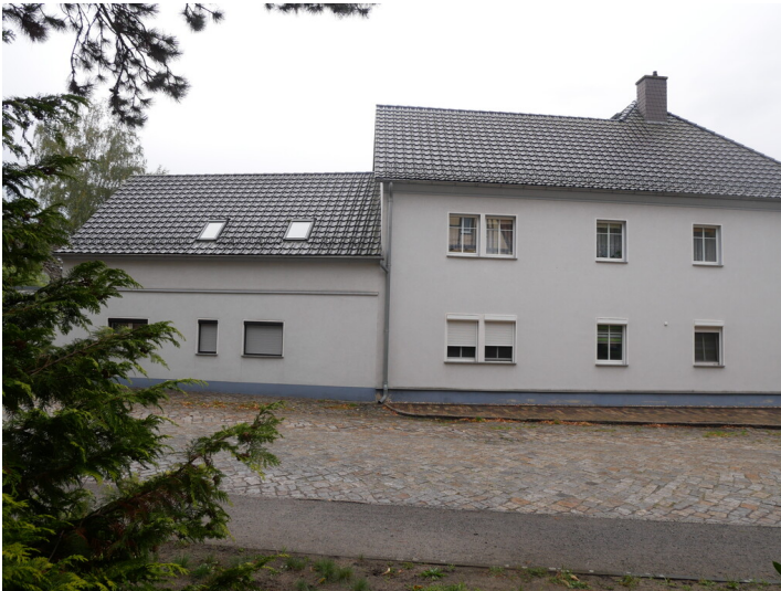
ehem. Bäckerei und späteres Kaufhaus in der Von-Delius-Straße Fotograf/Urheber: Dr. Barbara Kündiger
