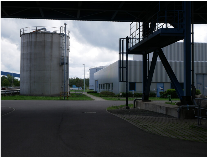
Wasseraufbereitungsanlage Fotograf/Urheber: Franz Dietzmann
