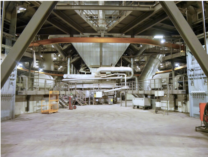
Kesselhaus Fotograf/Urheber: Franz Dietzmann
