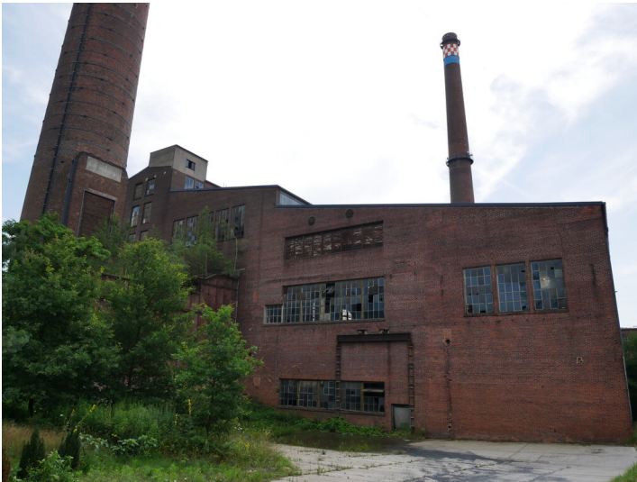
Kraftwerk Plessa Fotograf/Urheber: Kirsten Krepelin
