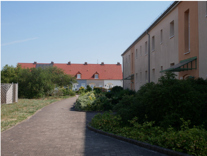
Bauabschnitt V der Wandelhofsiedlung Fotograf/Urheber: Dr. Barbara Kündiger
