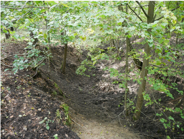
Tiefbaubruchfeld Grube Agnes Fotograf/Urheber: Franz Dietzmann
