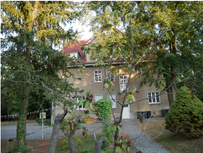
Direktorenvilla der Lauchhammer AG Fotograf/Urheber: Dr. Barbara Kündiger
