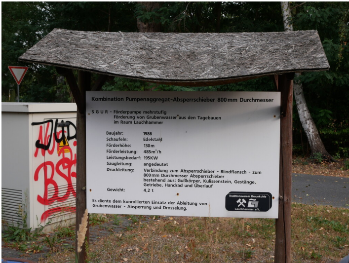
Pumpenaggregat- Absperrschieber Fotograf/Urheber: Kaja Boelcke
