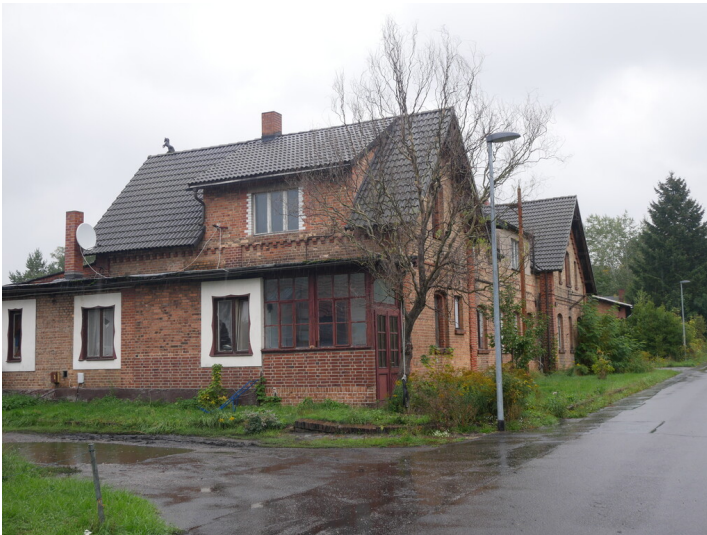
Alte Verwaltung Plessaer Braunkohlewerke Fotograf/Urheber: Dr. Barbara Kündiger
