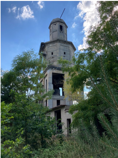
Bertzitwerk Fotograf/Urheber: Tanja Trittel
