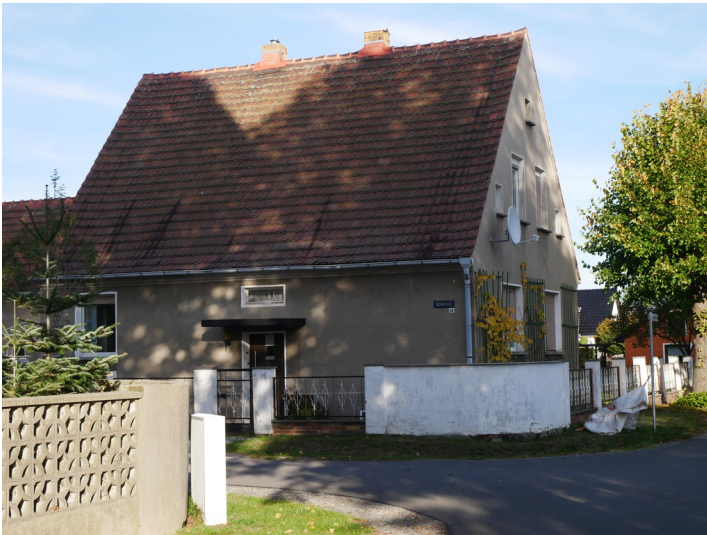
Siedlungshäuser für Grube Agnes Fotograf/Urheber: Dr. Barbara Kündiger
