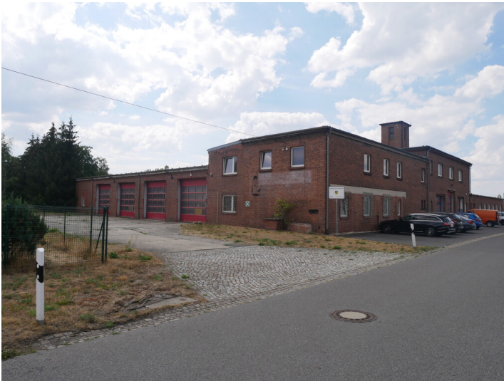
Werkfeuerwehr Großkokerei Lauchhammer Fotograf/Urheber: Stephan Redecker
