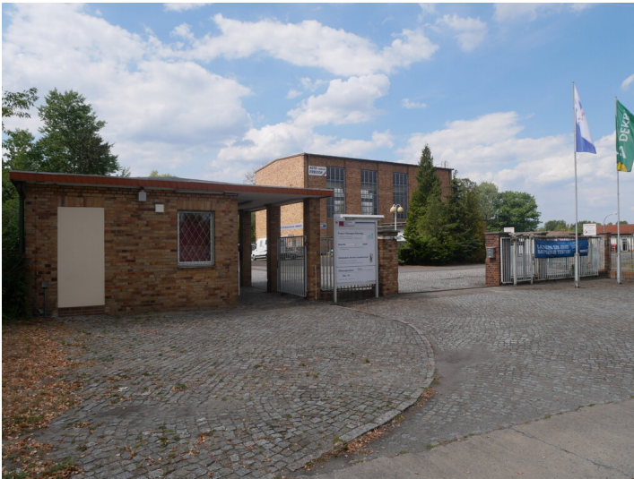
Industriesauerstoff-Anlage der Großkokerei Lauchhammer Fotograf/Urheber: Stephan Redecker
