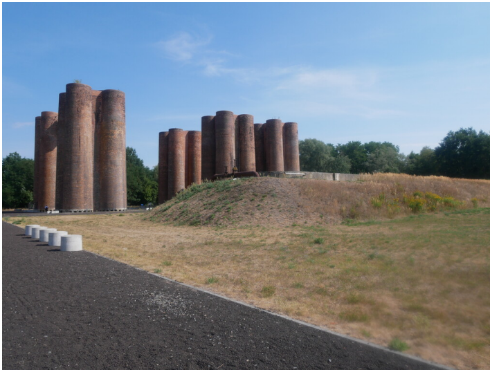
Biotürme und Belebtschlammbecken Großkokerei Lauchhammer Fotograf/Urheber: Dr. Barbara Kündiger
