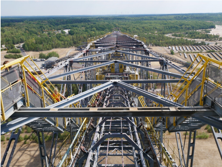
Abraumförderbrücke 36 F60 Fotograf/Urheber: Kaja Boelcke
