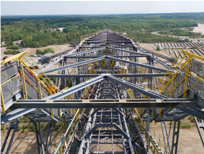
Abraumförderbrücke 36 F60 Fotograf/Urheber: Kaja Boelcke
