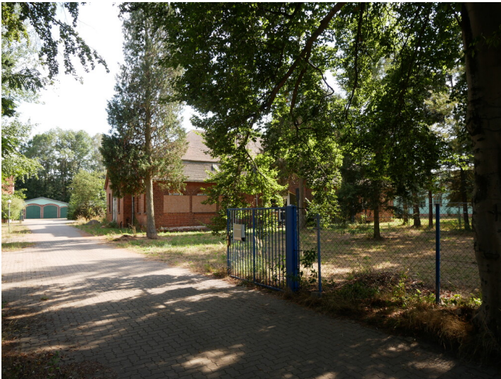
Wasserwerk Dolsthaida Fotograf/Urheber: Franz Dietzmann
