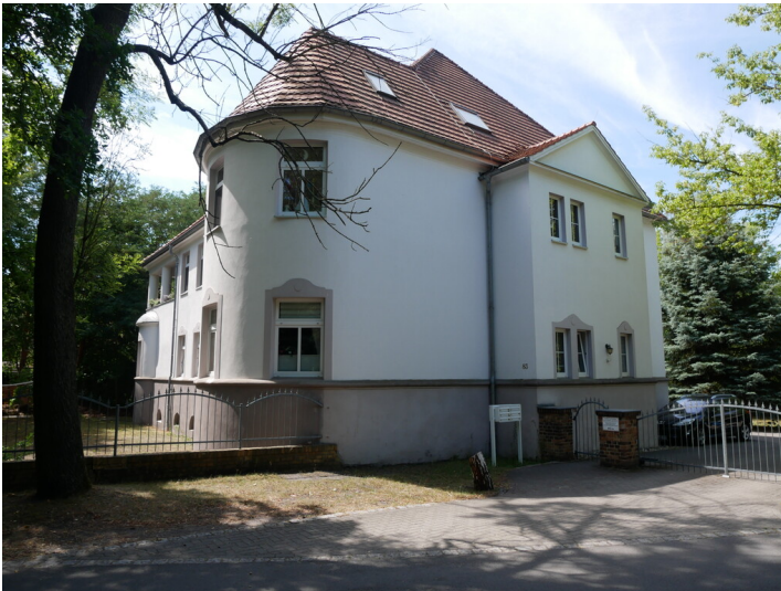
Beamtenwohnhaus der Brikettfabrik Milly Fotograf/Urheber: Franz Dietzmann
