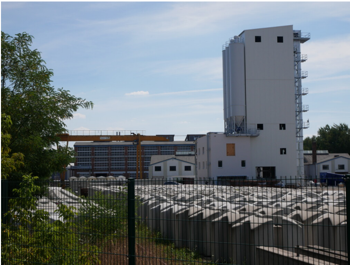
Hauptwerkstatt Lauchhammer-West Fotograf/Urheber: Franz Dietzmann
