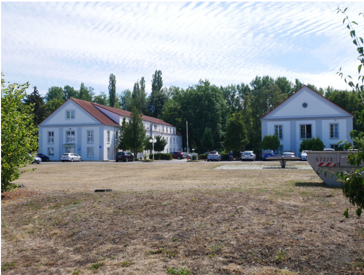
Lehrlingswohnheim des VEB BKK Lauchhammer Fotograf/Urheber: Kaja Boelcke
