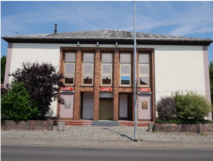
Versorgungsbauten für BUBIAG Bauarbeiter Fotograf/Urheber: Dr. Barbara Kündiger
