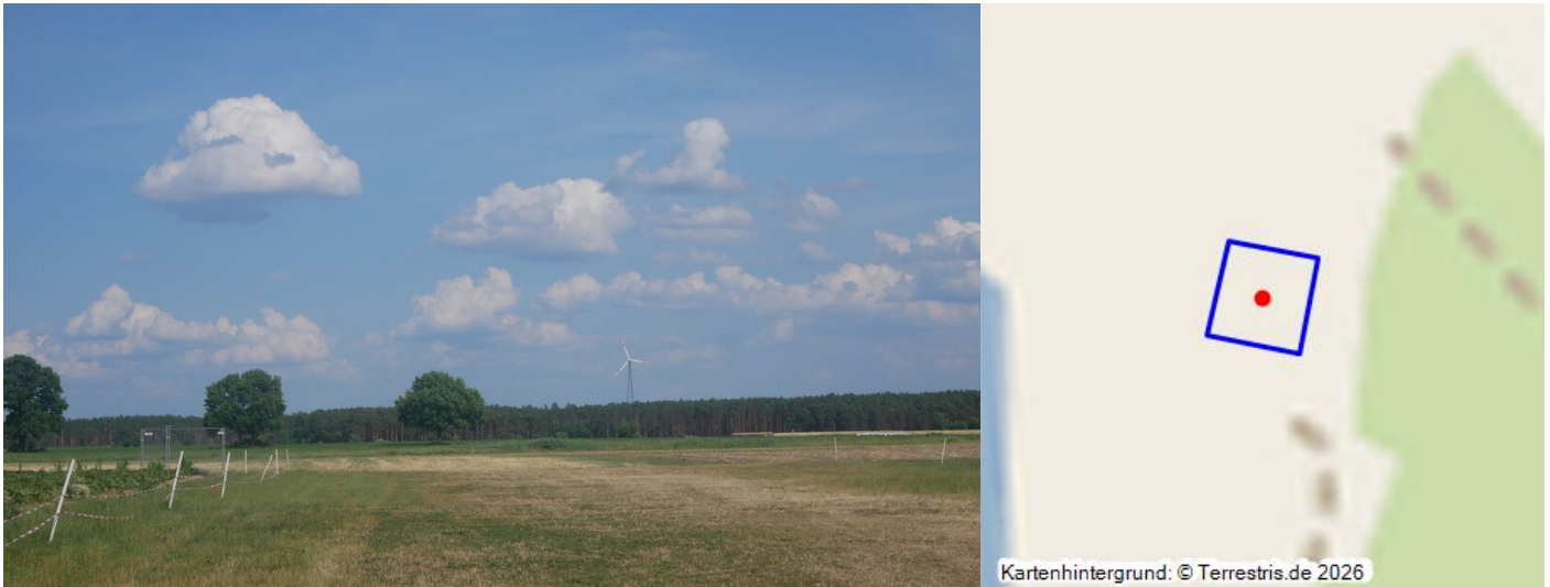
Windenergieanlage Laasow Fotograf/Urheber: Franz Dietzmann
