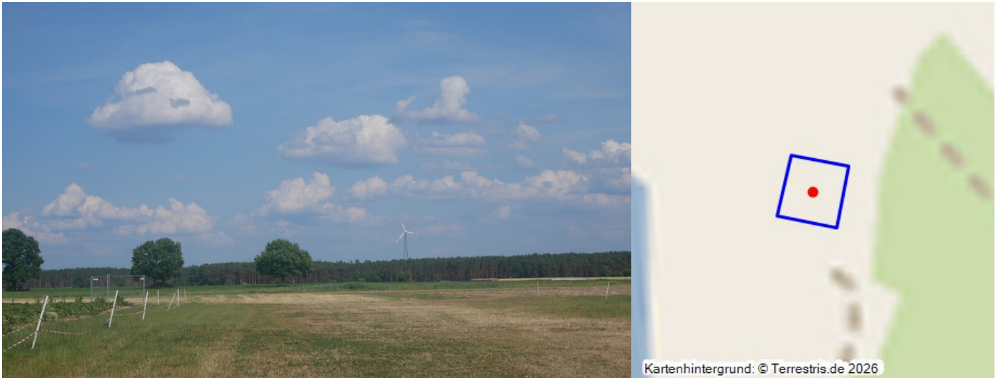
Windenergieanlage Laasow Fotograf/Urheber: Franz Dietzmann
