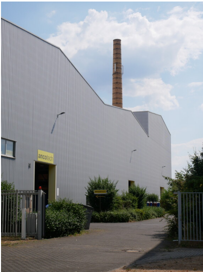
Schornstein Takraf Fotograf/Urheber: Kaja Boelcke
