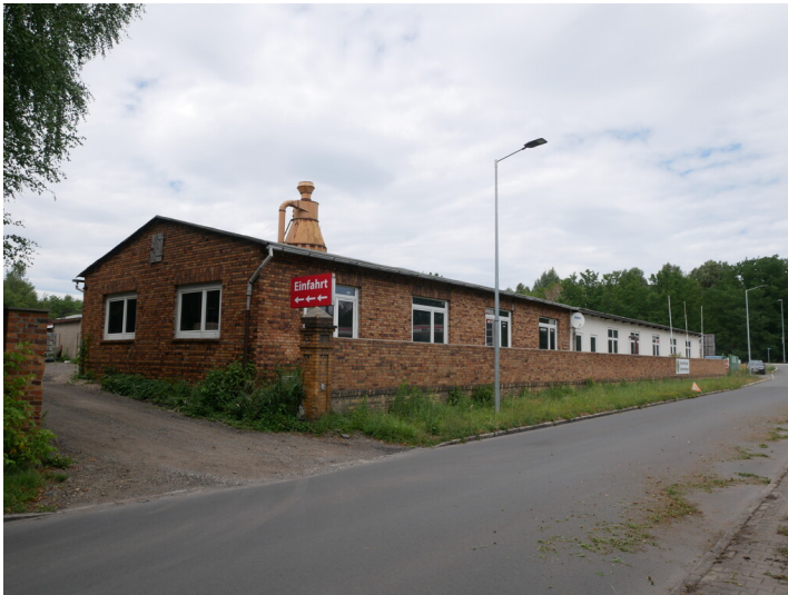
Werkstätten der Brikettfabrik Milly Fotograf/Urheber: Kaja Boelcke
