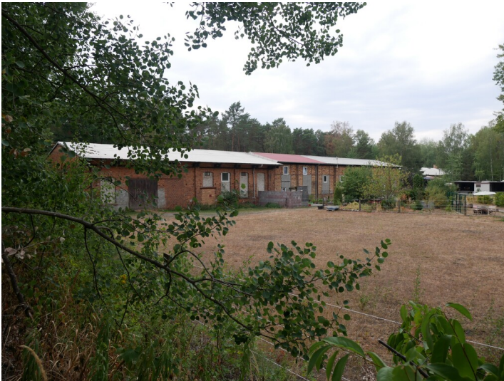
Tagesanlagen der Grube Marie-Anne Fotograf/Urheber: Kaja Boelcke
