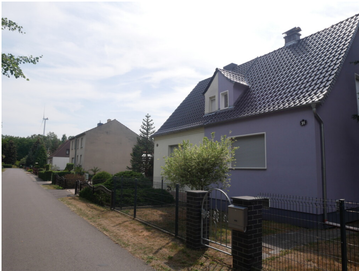
Siedlung Grube Ferdinand Fotograf/Urheber: Franz Dietzmann
