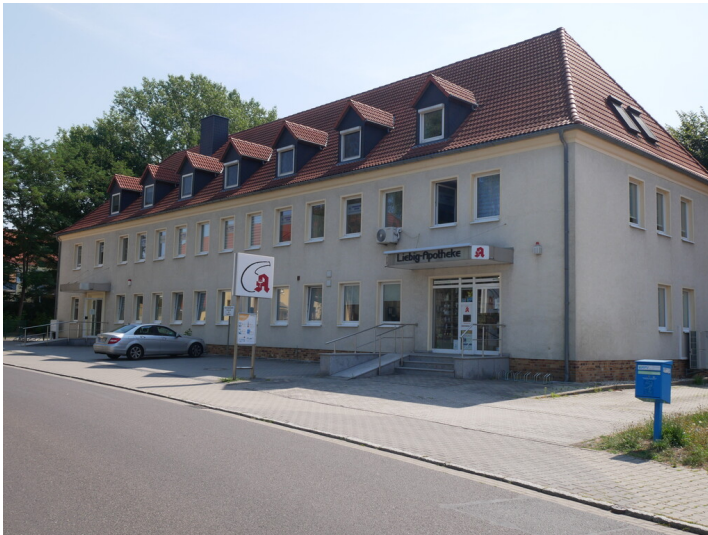
Betriebskindergarten der Brabag Fotograf/Urheber: Dr. Barbara Kündiger
