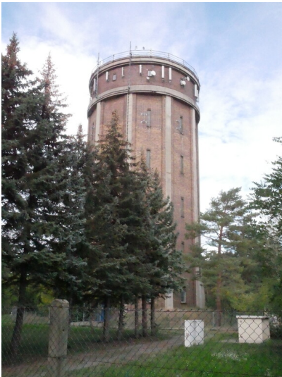
Wasserturm Lauchhammer-Ost Fotograf/Urheber: Franz Dietzmann
