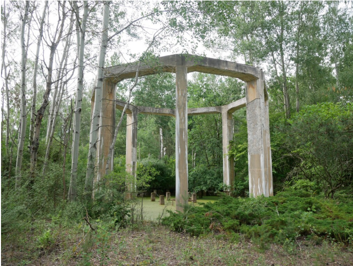
Kühlturmrest Chemowerk Fotograf/Urheber: Kaja Boelcke
