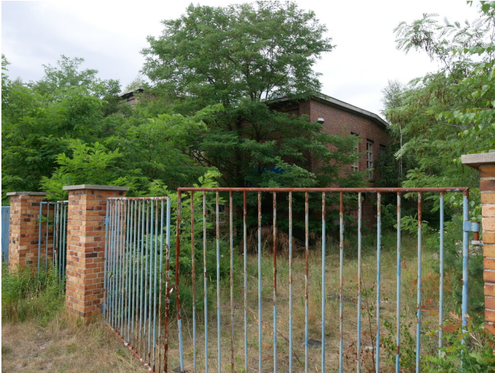
Hauptwerkstatt Mückenberg Fotograf/Urheber: Franz Dietzmann
