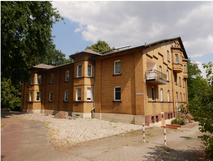
Kraftzentrale Fotograf/Urheber: Franz Dietzmann
