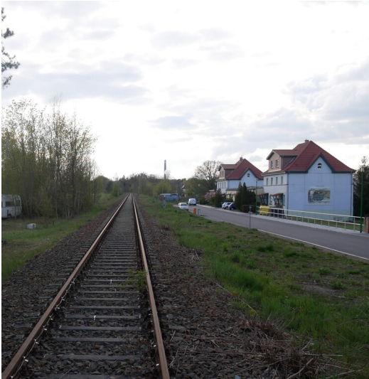
Kohlebahn Freienhufen Fotograf/Urheber: Franz Dietzmann
