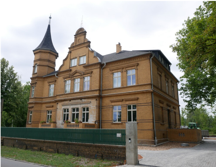
Direktorenvilla der Brikettfabrik Milly Fotograf/Urheber: Kaja Boelcke
