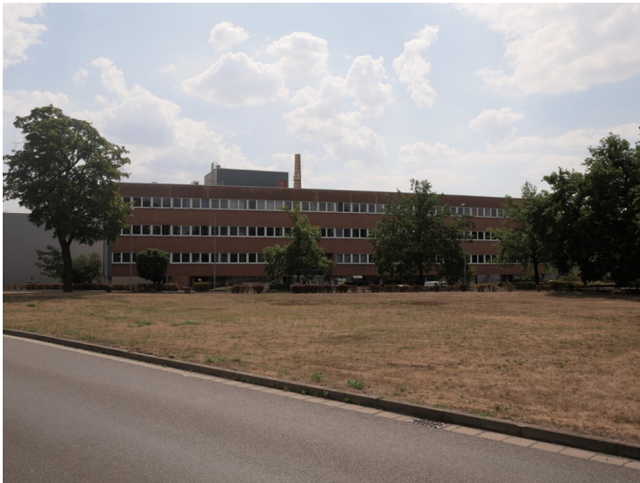
Takraf Lauchhammer Fotograf/Urheber: Franz Dietzmann
