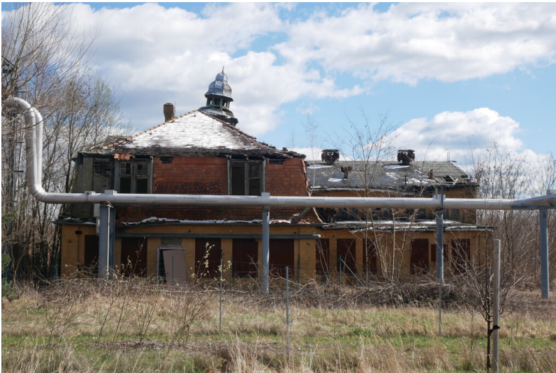
Zechenhaus der Brikettfabrik Marie-Anne Fotograf/Urheber: Franz Dietzmann
