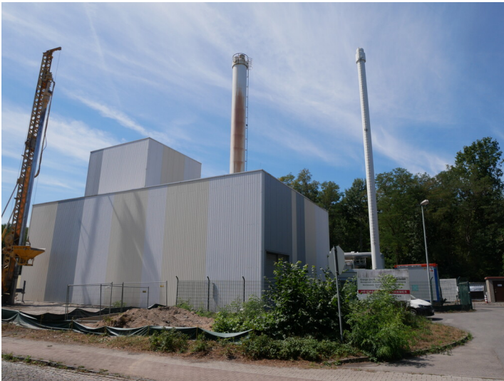
Heizkraftwerk Lauchhammer Fotograf/Urheber: Franz Dietzmann
