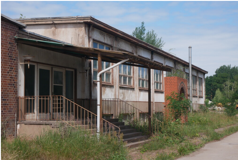
Klinkerwerk Buchwäldchen Fotograf/Urheber: Dr. Barbara Kündiger
