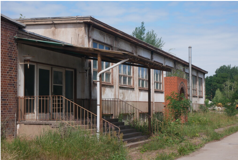
Klinkerwerk Buchwäldchen Fotograf/Urheber: Dr. Barbara Kündiger
