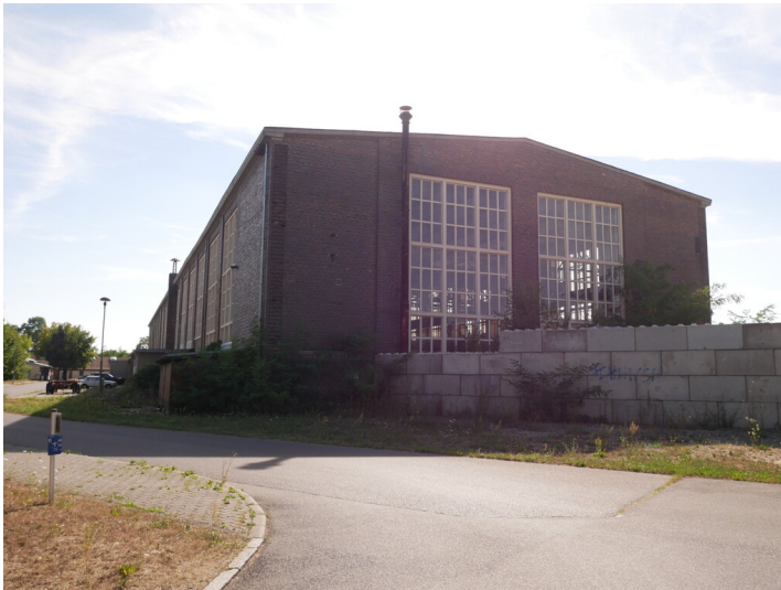
Restgebäude Hauptwerkstatt-Süd und Lehrwerkstatt Fotograf/Urheber: Franz Dietzmann
