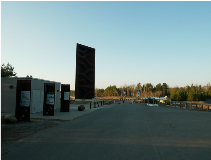
Rostiger Nagel Fotograf/Urheber: Kirsten Krepelin
