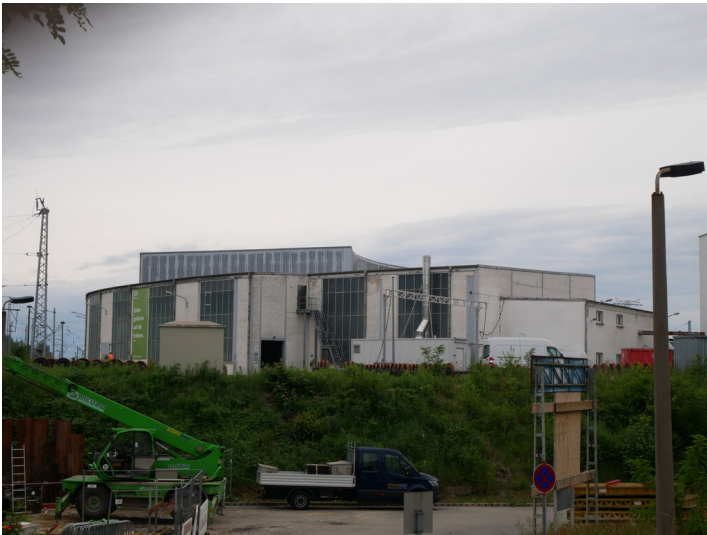
Ringlokschuppen Fotograf/Urheber: Tanja Trittel
